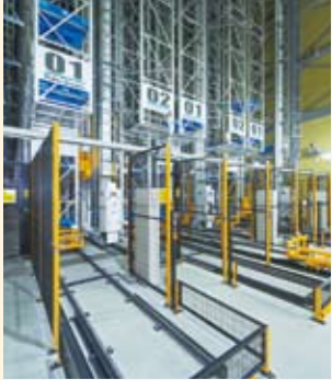
パレット自動倉庫
